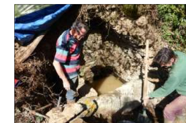
Les travaux commencent
